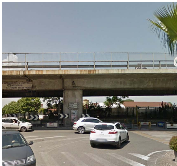
Figura 22 – L'attuale cesura con l'abitato di Caravita è accentuata dalla presenza del cavalcavia della SS 162.
