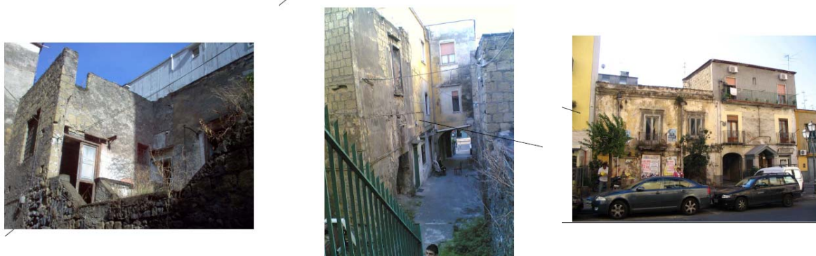
Figura 15 – Foto dello stato di fatto prima dell'intervento
